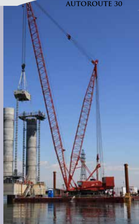
Installation d'un chevêtre préfabriqué au pont de Beauharnois
