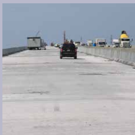
Progrès de la construction du tablier
